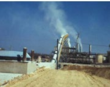
储料堆卸料机
