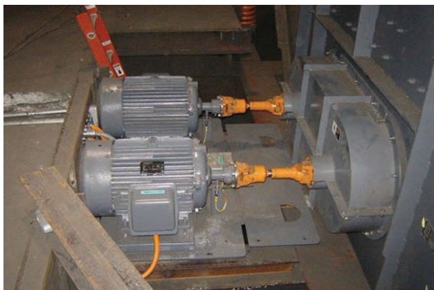
使用木轨（上图）减少清洗过程中对砂箱损坏的原落砂系统；新Delta-Phase®落砂系统上的驱动系统（下图）。
